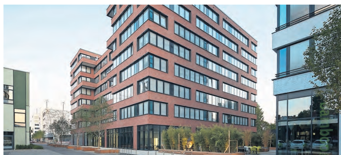
Neue Adresse: In dem Gebäude EUREF-Campus 10/11 ist jetzt die WOLFF & MÜLLER-Niederlassung. Foto: Andreas Muhs
