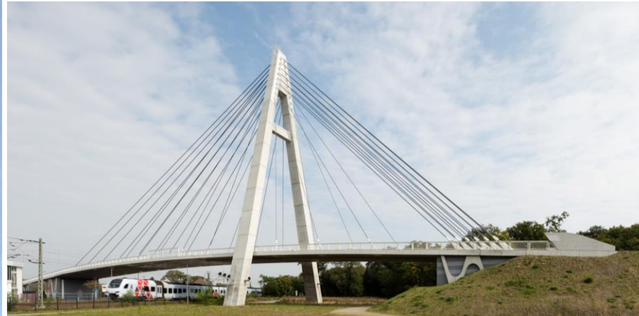
Schrägseilbrücke in Raunheim
