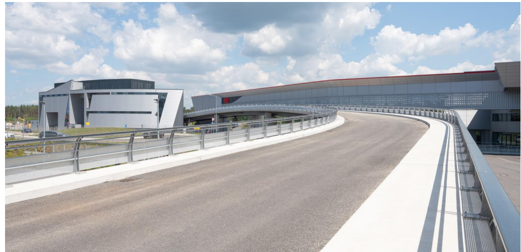
LKW Brücke SEW Graben-Neudorf
