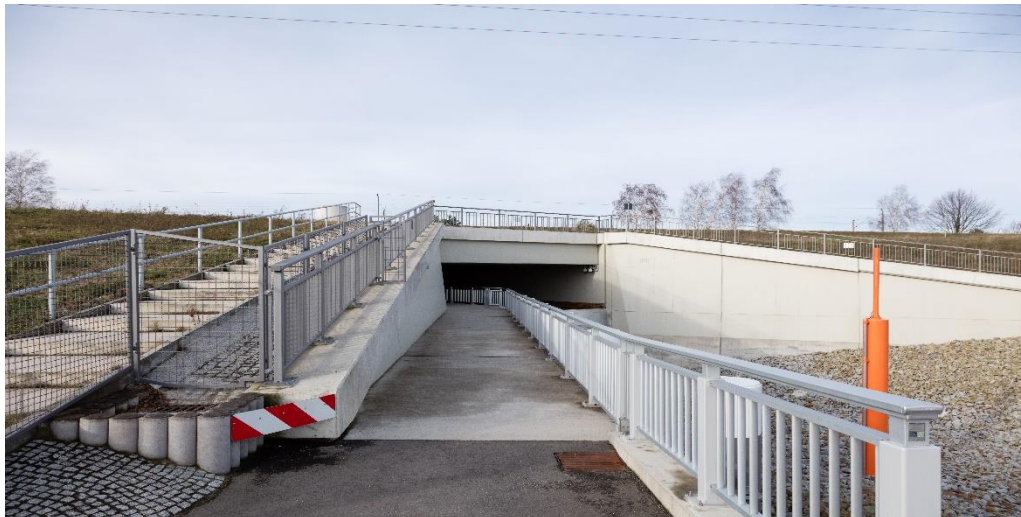
Unterquerung der B169 und Eisenbahnstrecke in Senftenberg
