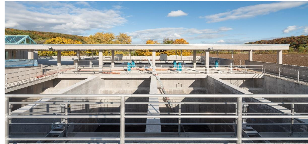
Kläranlage Tübingen, 4. Reinigungsstufe
