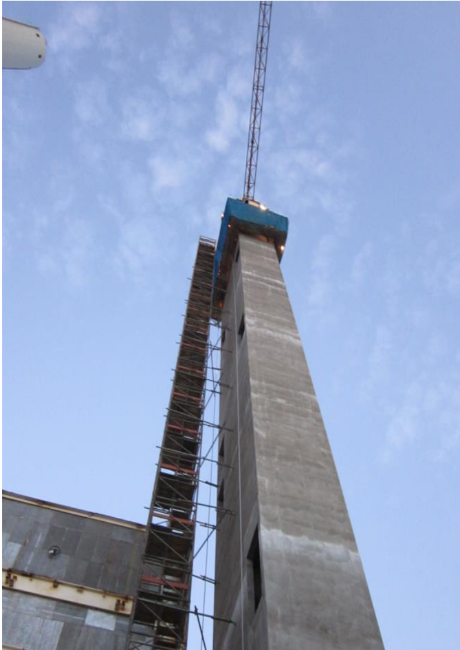
Modernisierung Heizkraftwerk MB in Sindelfingen
