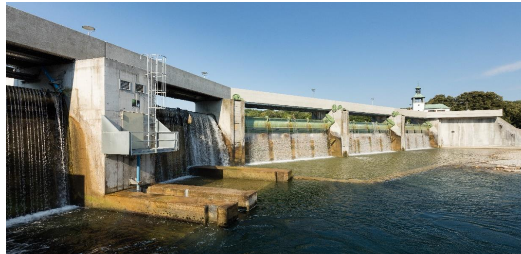
Wasserkraftanlage in Augsburg
