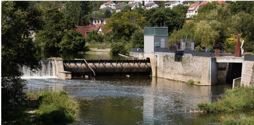
Wasserkraftanlage in Horb am Neckar
