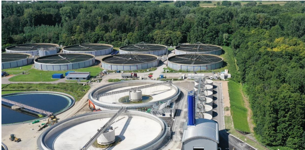
Klärwerk Karlsruhe Neubau Adsorptionsanlage
