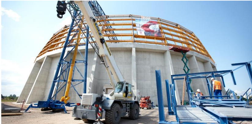
Kohlelager Kraftwerk Staudinger, Großkrotzenburg
