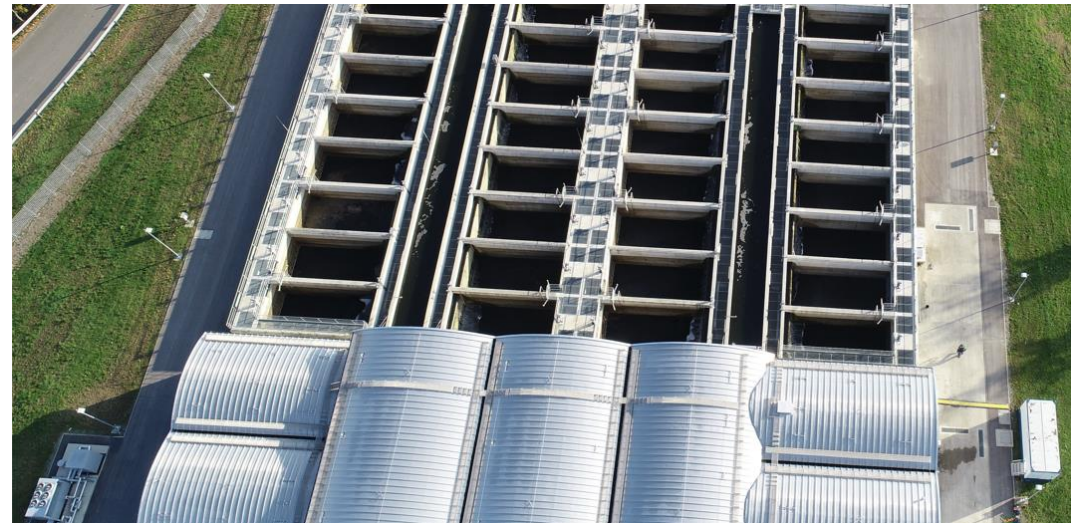
Klärwerk Karlsruhe Neubau Filtrationsanlage
